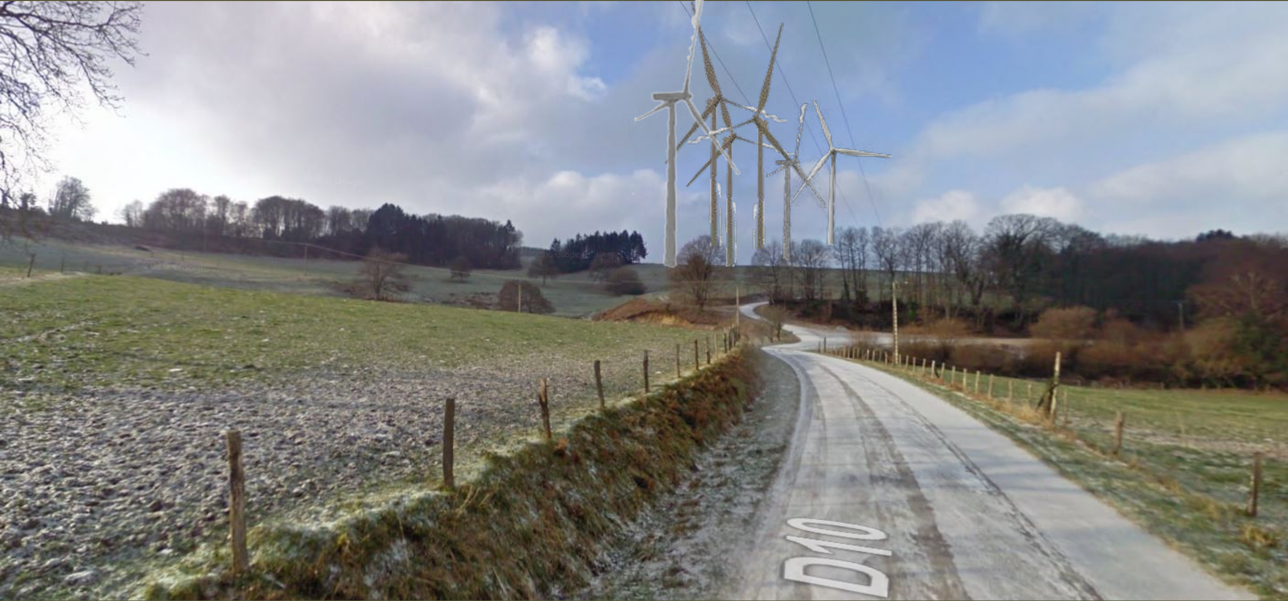
Souliers, départementale D10 E6 à 600m
